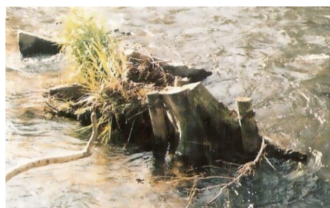
Figure 15: Principe d'aménagement de souches maintenues par des pilotis en bois
