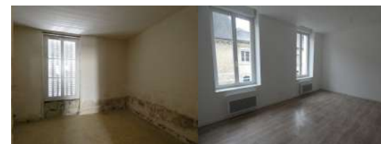
Exemple de travaux réalisés dans le cadre de l'OPAH-Ru
