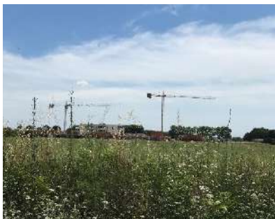
Figure 29 : Travaux de constructions d'habitations dans la zone de repli identifiée du site de Saint Nazaire n°22.
