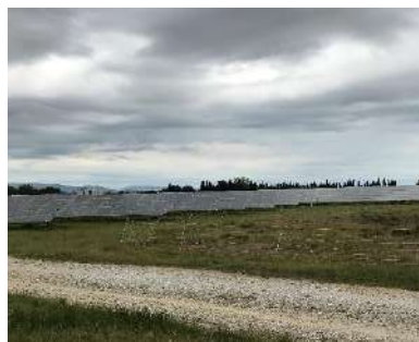
Figure 30 : Centrale photovoltaïque de Torrelles dans la zone de repli identifiée du site du Canet n°1.
