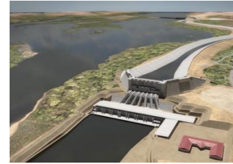
Figure 4 : Barrage hydraulique de Nachtigal (NGE, 2019)
