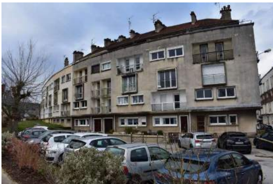
Figure 8 – Photographie d'un immeuble rue du Huit mai à Caudebec-en-Caux commune déléguée de Rives-en-Seine ©Marianne Duboc
