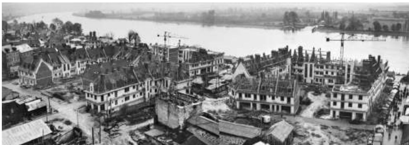
Figure 10 – Panorama vue sur l’arrière de la Maison des Templiers, rue Guillaume Letellier, 1950-1951 ©Collection Huon
