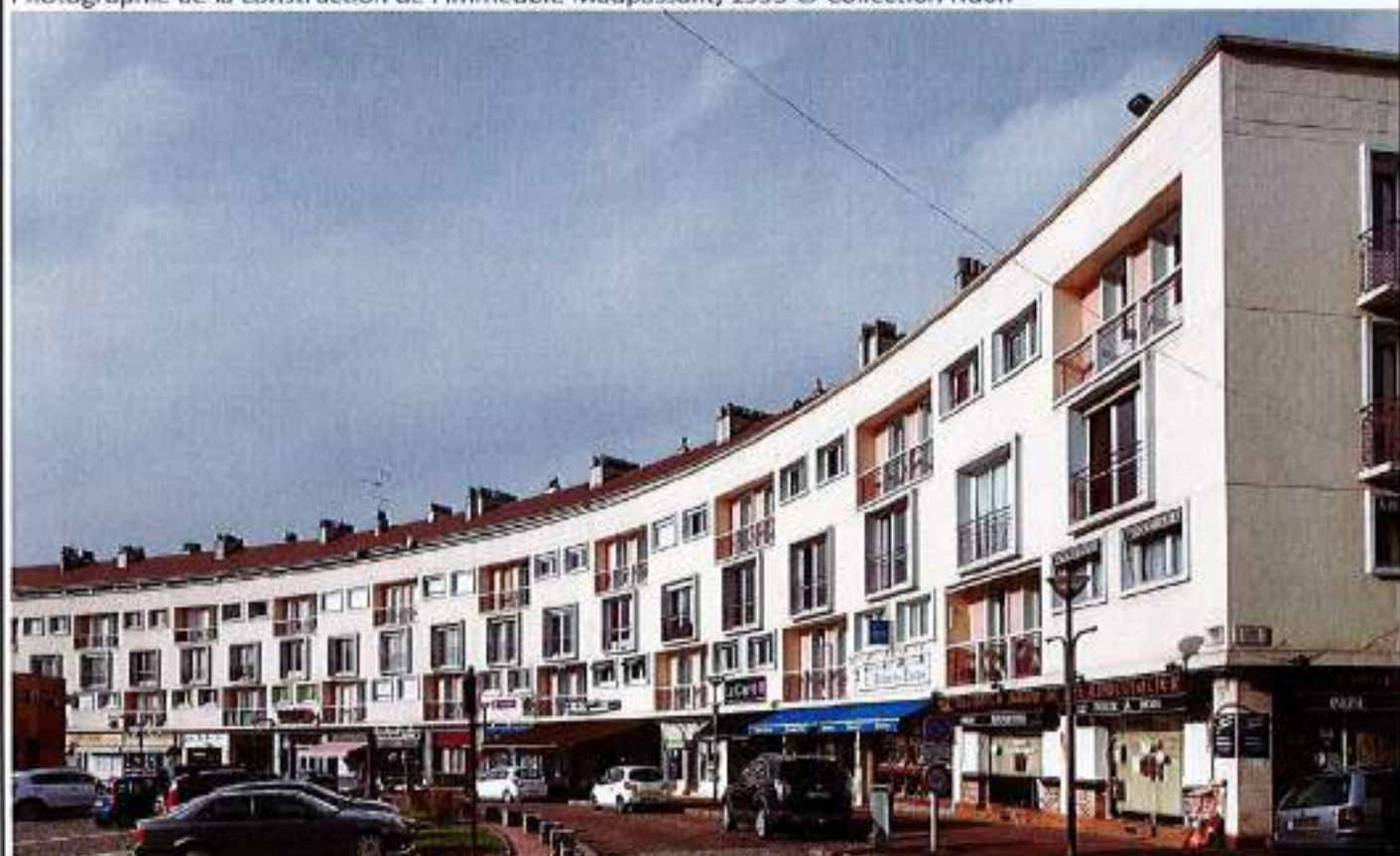
Photographie de l'immeuble Maupassant, vue de la place d'Armes ©Christophe Kollmann
