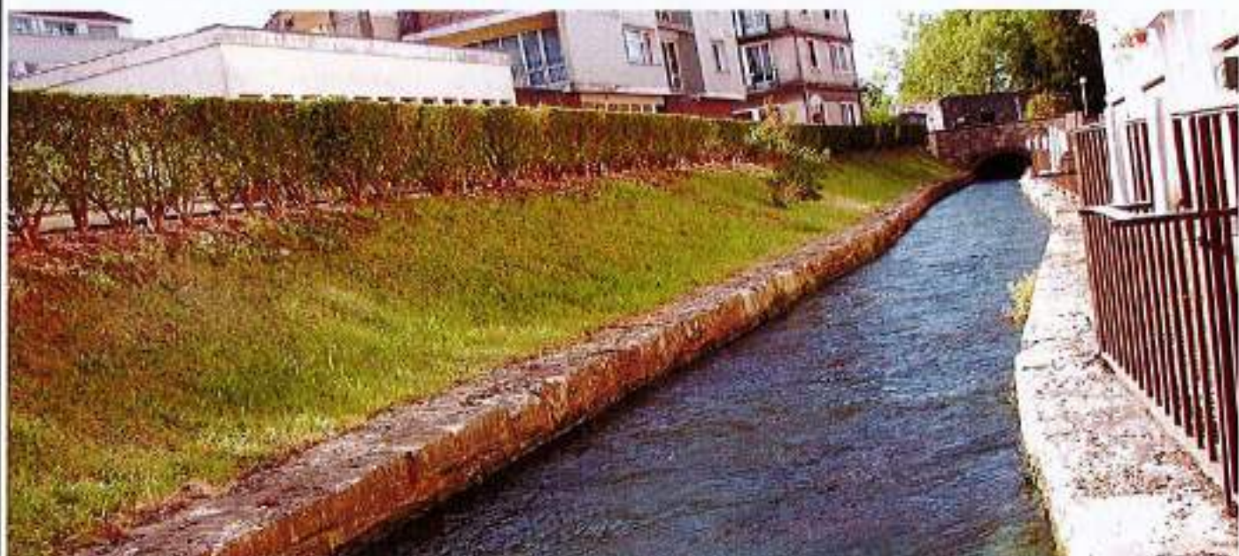
Photographie de l'Ambion, vue de la rue de L'Ambion © Ville de Rives-en-Seine
