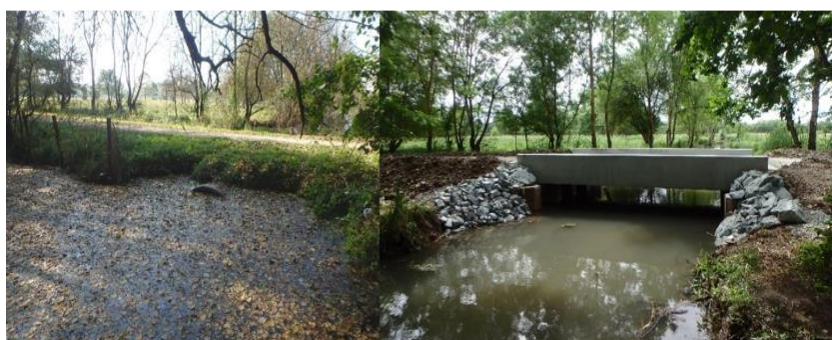
Photo d'un ouvrage restauré (buse) sur la boire de Corzé. Photo prise par Bertrand Degrieck.
