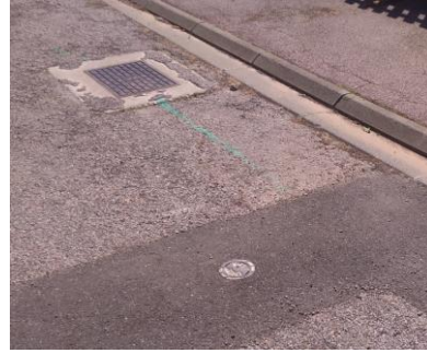
Photo n°2 : Plaque télécom et bouche à clé
