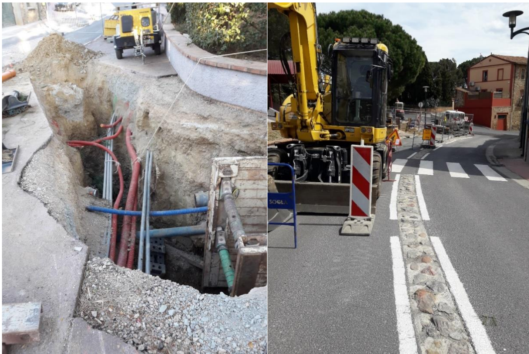
Photos n°10 et n°11: Travaux de terrassement de tranchée (PURE Environnement SAS)
