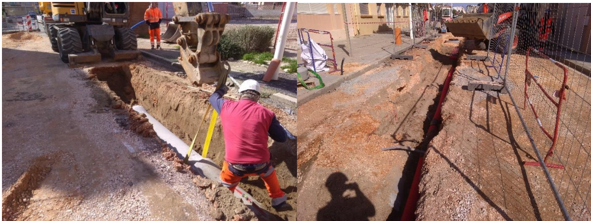
Photos n°7 et n°8 : Pose d'une canalisation (photos personnelles)
