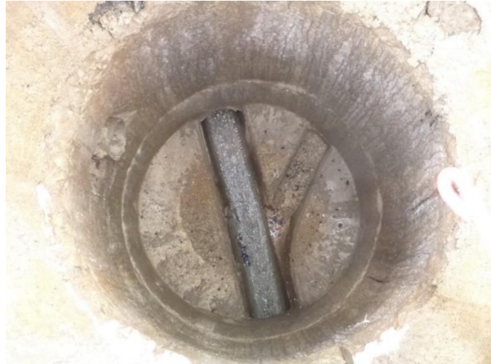
Photos n°3 et n°4 : Extérieur et intérieur d'un regard (PURE Environnement SAS)
