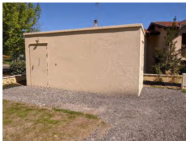
Figure 7 : un NRO à Moliets-et-Maa (Landes)
