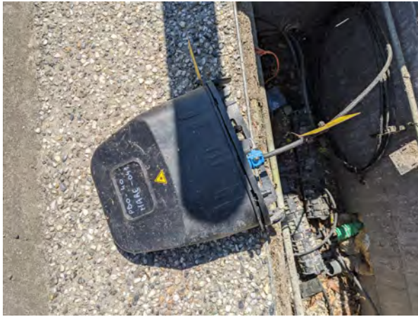
Figure 22 : Boîte taille 0 souterraine, capacité 48 FO
