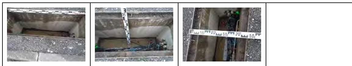
Vues complémentaires avec repères métriques pour faisabilité d'implantation de boîtiers ou manchons dans les chambres
