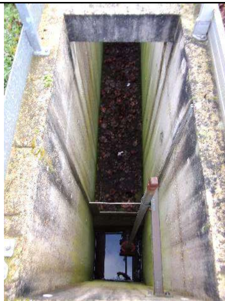
Canal de comptage du trop plein et des eaux by-passées avec préleveur automatique
