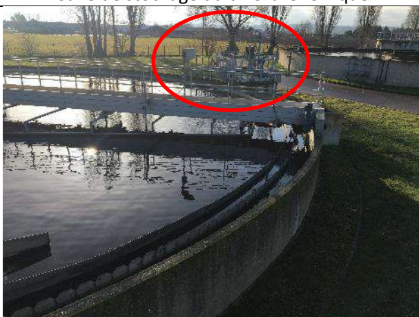
Clarificateurs racclés et, entre les deux, puits de recirculation (entouré en rouge)
