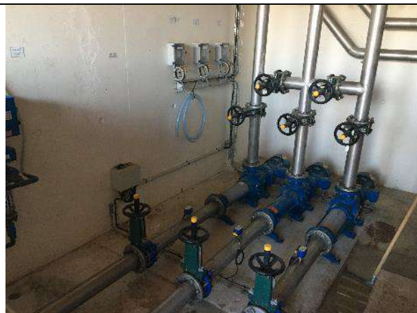
Système d'extraction pour envoi vers les centrifugeuses
