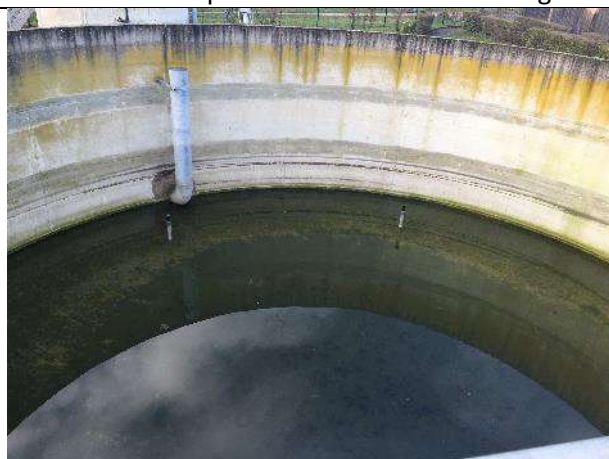
Bassin dit de stockage-restitution ou d'orage, capacité de 400m 3
