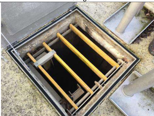
Regard amont d'arrivée des eaux brutes
