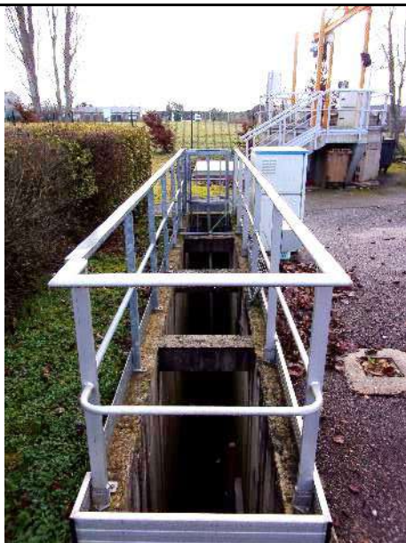
Canal de comptage du trop plein et des eaux by-passées avec préleveur automatique
