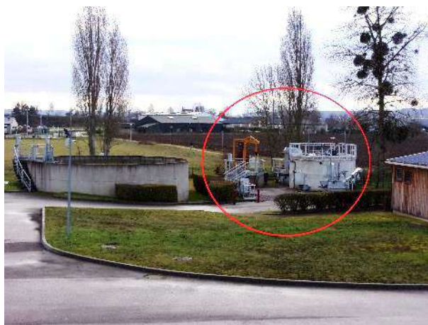
A gauche : bassin d'orage (stockage-restitution) En rouge : éléments de la photo ci-à gauche A droite : aperçu partiel du local des surpresseurs file 1
