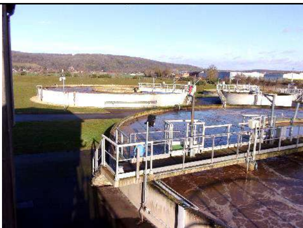
Premier plan : Bassin d'aération file 1 Second plan, de gauche à droite : Bassin d'aération file 2 et bassin de répartition
