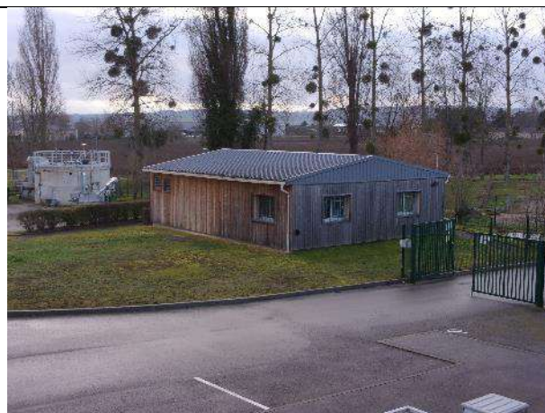
Ancien local réhabilité, avec une partie surpresseurs d'air file 1 et une partie arrivée électrique et armoire file 1
