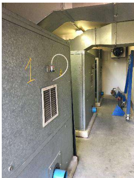
Surpresseurs vieillissants file 1
