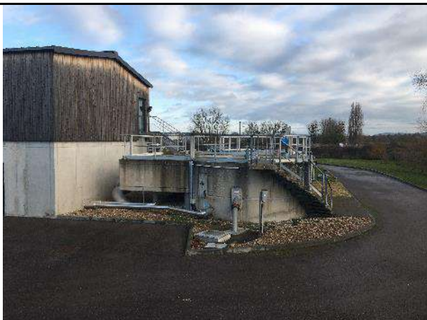
A gauche, ancien local réhabilité pour accueillir les deux dégrilleurs fins et le système d'extraction des sables. Au centre, dégraisseur-déssableur combiné.
