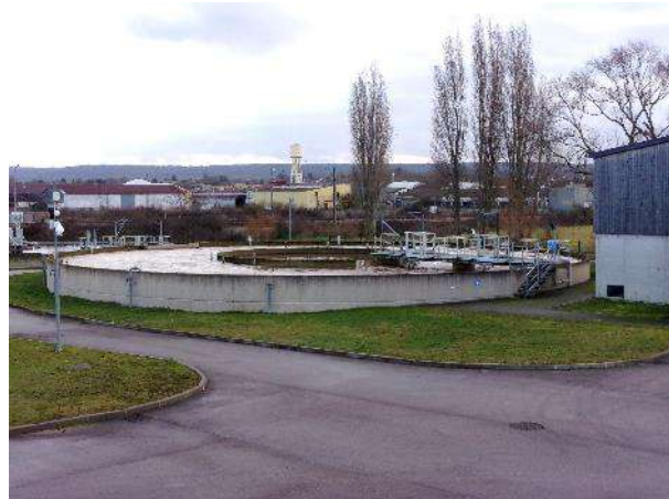
Bassin d'aération file 1
