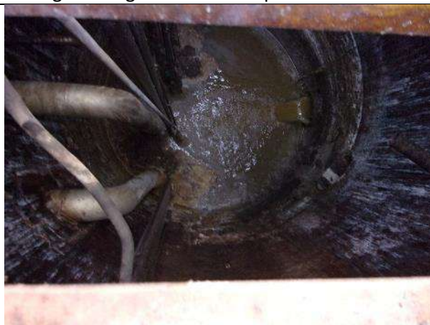
Vue de l'intérieur du poste de relèvement
