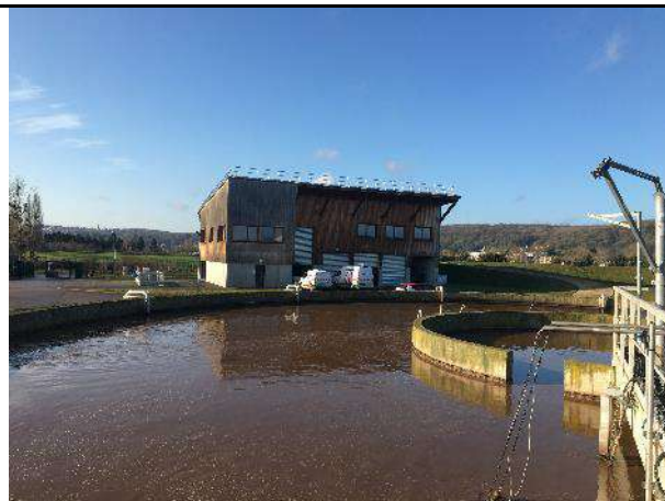
Mauvais fonctionnement des raquettes du bassin d'aération file 2, perturbation des flux (Spiral flow). Vérification des raquettes à programmer.
