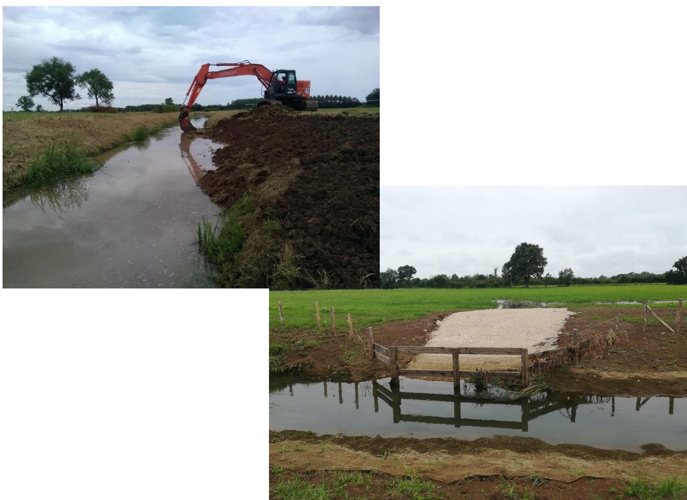
Figure 22 : Illustration des travaux réalisés sur le Nacey à Flammerans (21)
