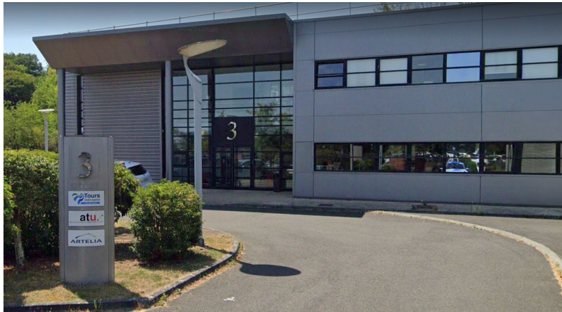
Figure 2: Locaux de l'agence Val de Loire d'Artelia Villes & Territoires
