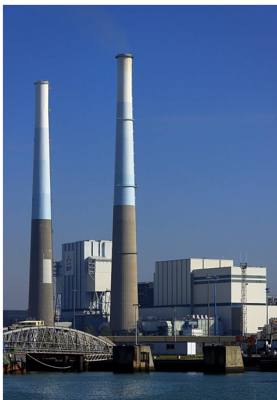
Figure 16 : Centrale thermique du Havre (crédit photo : Degrémont Anthony)
