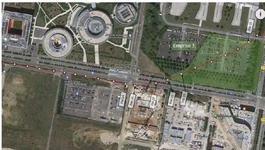
Figure 5 : Emprise des travaux des piles 21 et 20
