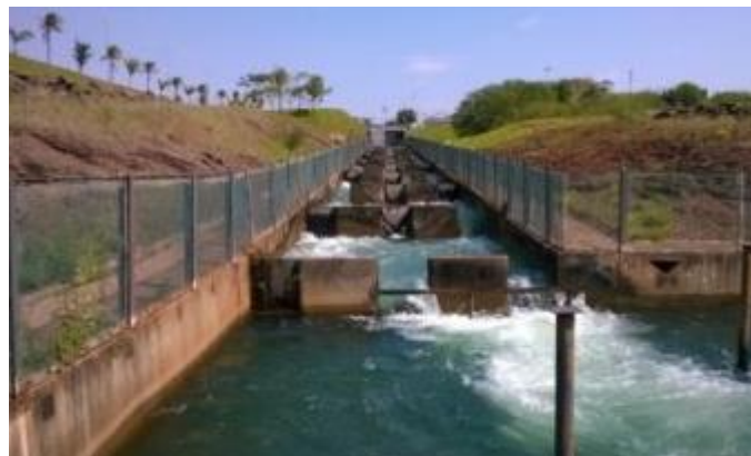
Figure 2 : Passe à poissons du barrage de Porto Primavera (Source : Association Initiatives pour l'avenir des grands fleuves)
