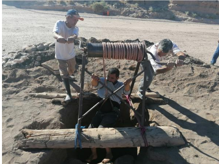
Photo 1 : Techniciens de la khattara lors du curage d'un puit d'aération(31)
