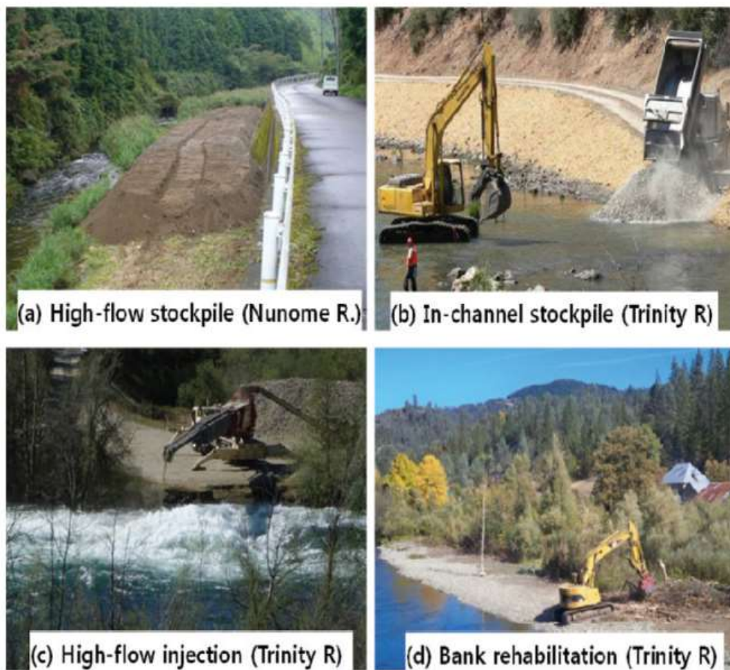
Figure 1 : Techniques de recharge sédimentaire des cours d'eau (Ock et al., 2013)
