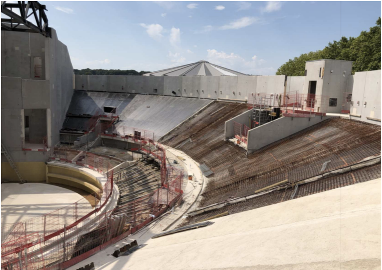
Figure 3. Photo personnelle prise avant la pose des gradins et pendant la réalisation de l'étanchéité sous-jacente bâtiment C
