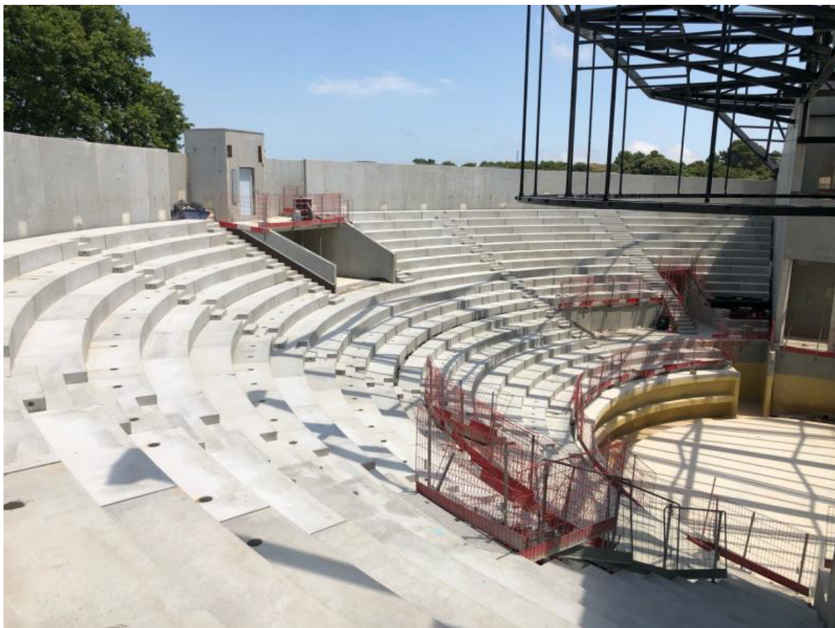
Figure 5. Photo personnelle prise après la pose des gradins bâtiment C
