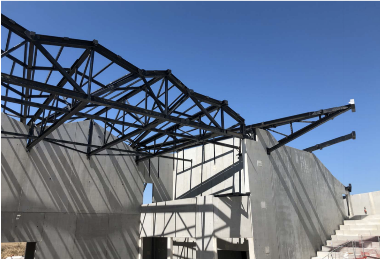
Figure 11. Photo personnelle de la réalisation de la charpente métallique réelle
