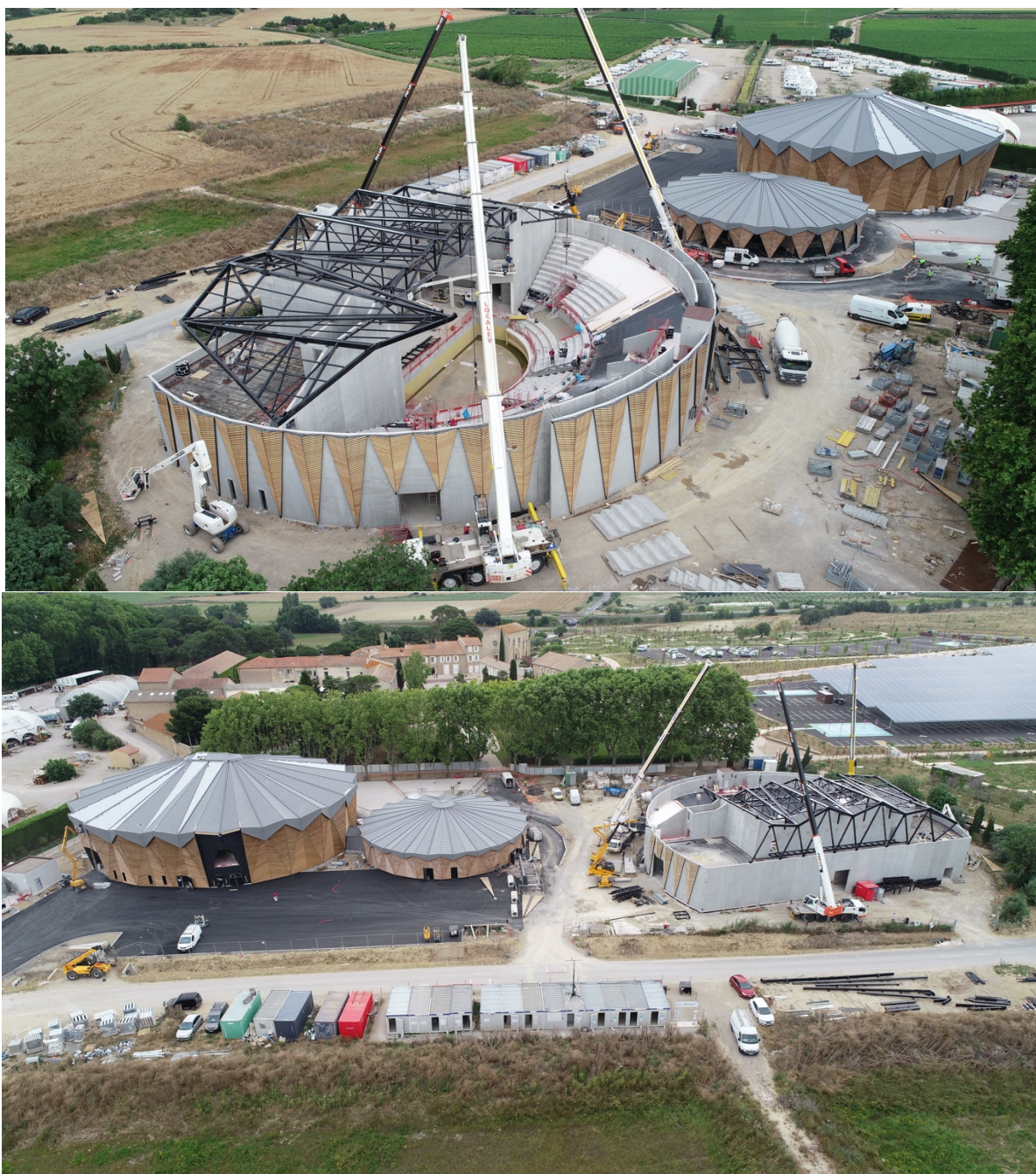
Figure 12. Reportage photo chronologique de l'avancée du chantier du domaine de Bayssan, Béziers (réalisé par un drone) Source : serveur du chantier
