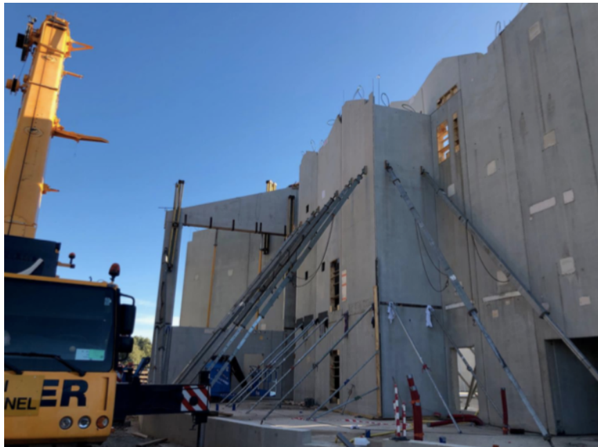
Figure 1. Photo personnelle du montage impressionnant des prémurs de 12 mètres de haut bâtiment C
