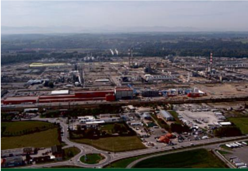
Figure 9 : plateforme industrielle de Lacq
