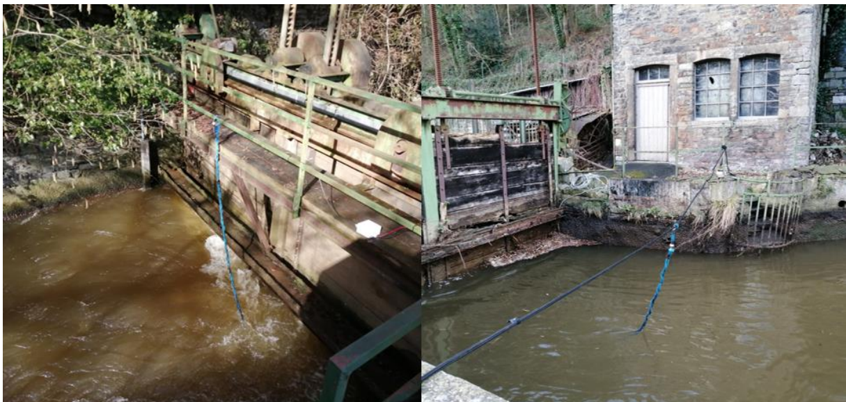
Antennes subaquatiques à l'entrée du canal de dérivation R06 (à gauche) et à la sortie R07 (à droite)
