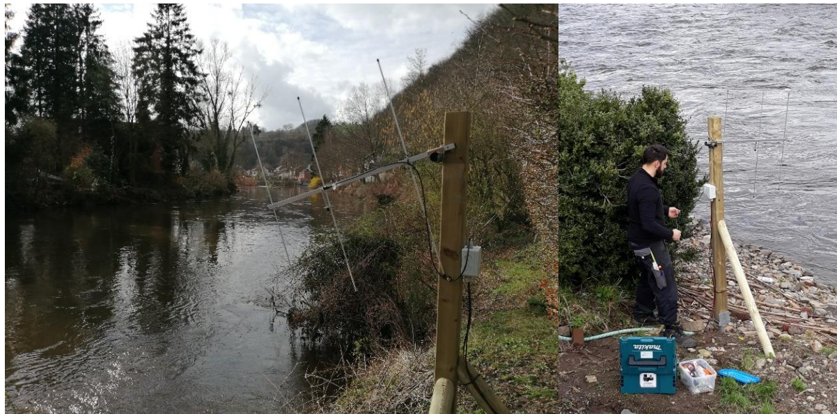
Antennes aériennes amont R11 (à gauche) et aval R12 (à droite)
