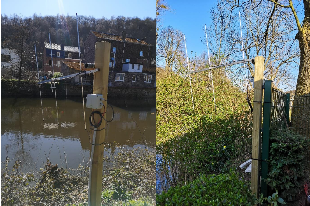
Antennes aériennes amont R01 (à gauche) et aval R04 (à droite)
