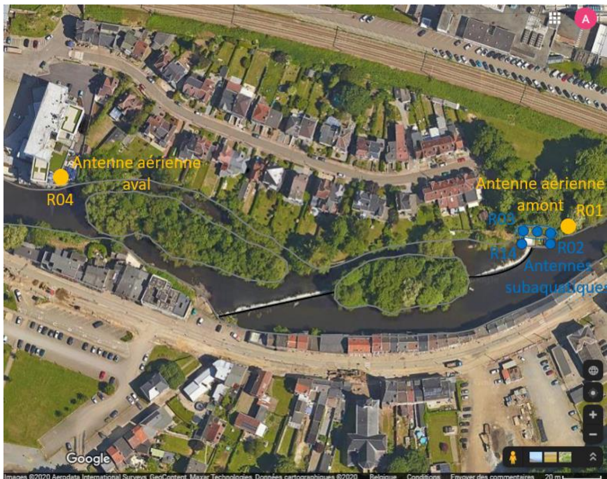
Figure 9 : Vue générale des antennes sur le secteur Chaudfontaine
