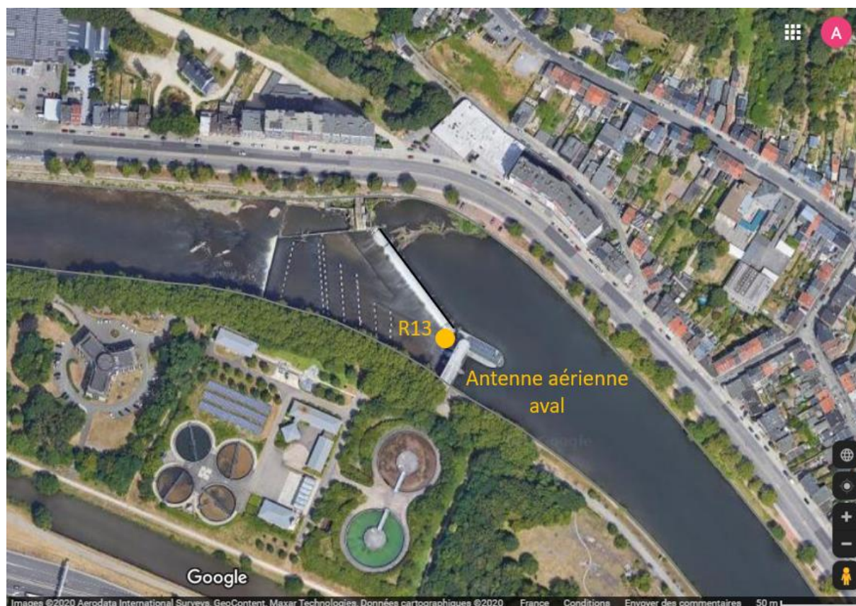
Figure 10 : Vue générale de l'antenne sur le secteur Liège
