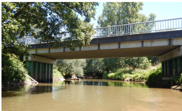
Fig. 5. Pont de la RD174 sur la Sélune
