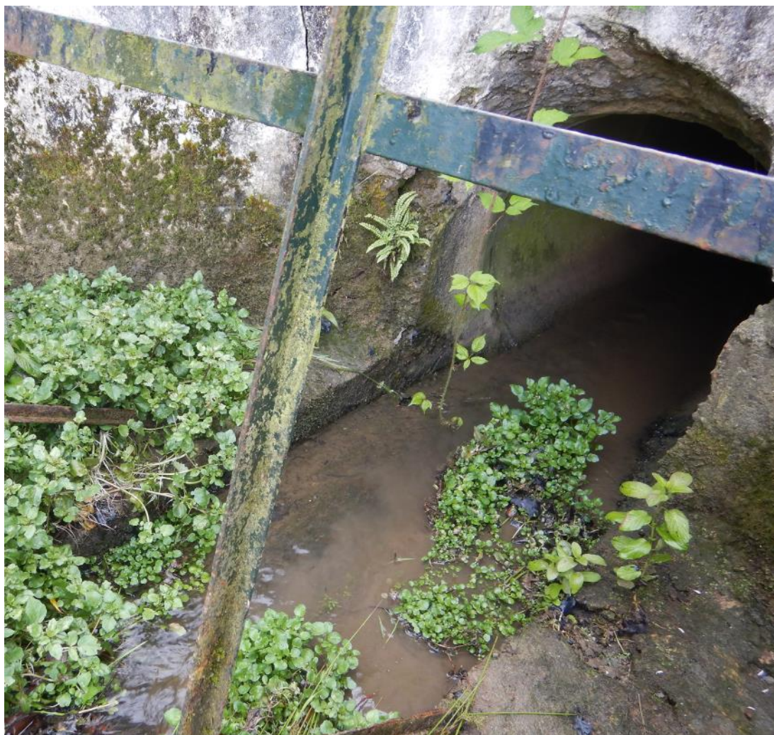
Début de l'ouvrage passant sous la D252
