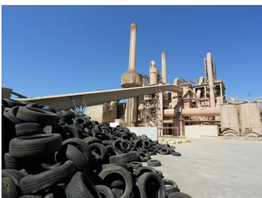
Atelier de valorisation de pneus de la cimenterie Lafarge de Martres-Tolosane (31)
