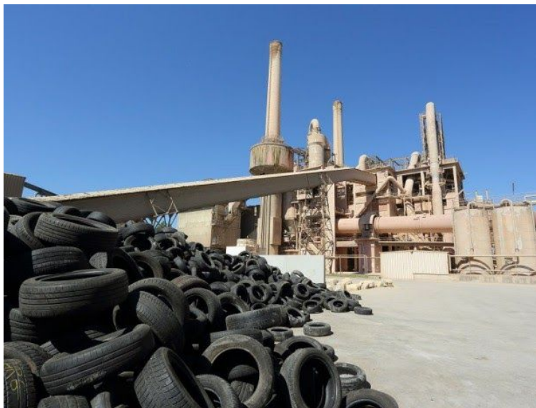
Atelier de valorisation de pneus de la cimenterie Lafarge de Martres-Tolosane (31) 20
