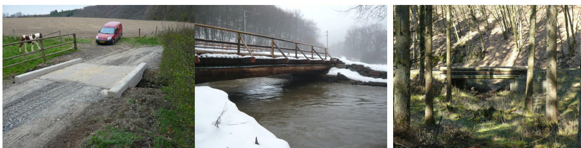
Figure 70: Possibilité d'aménagement des ponts en question. (1: Pont en béton adapté à des charges lourdes comme les machines agricoles, 2: En phase de crue du cours d'eau, 3: en état fini, ce type de pont s'intègre bien à la nature) Ces exemples sont constitués plutôt pour des chemins peu fréquentés tels que des chemins forestiers/ agricoles. (ANF luxembourgeoise: 2017)
