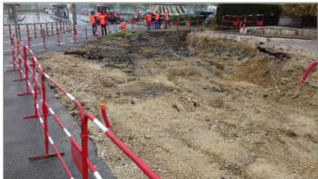
Figure 7 : Terrassement de la voie n°3. (Source : personne)
