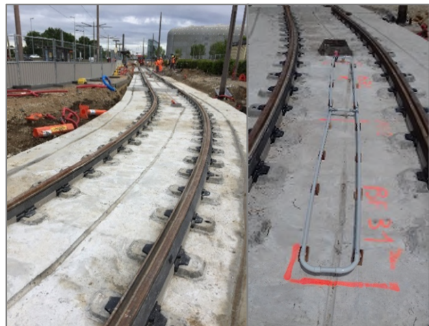
Figure 10 : Voie n°3 avec le rail posé et les circuits de voie. (Source : personnelle)
