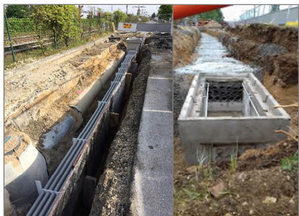
Figure 8 : Mise en place de la nouvelle multitubulaire. (Source : personne)
