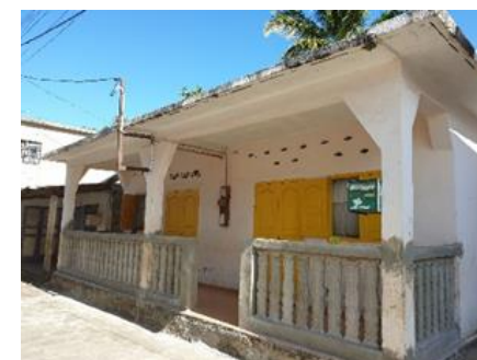
Figure 60 : Construction en dur sur le quartier de Dagoni, 2019
