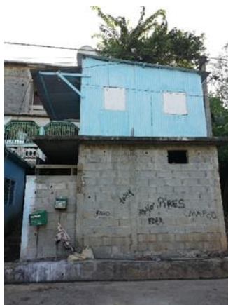
Figure 57 : Construction en semi-dur sur le quartier de Dagoni, 2019
