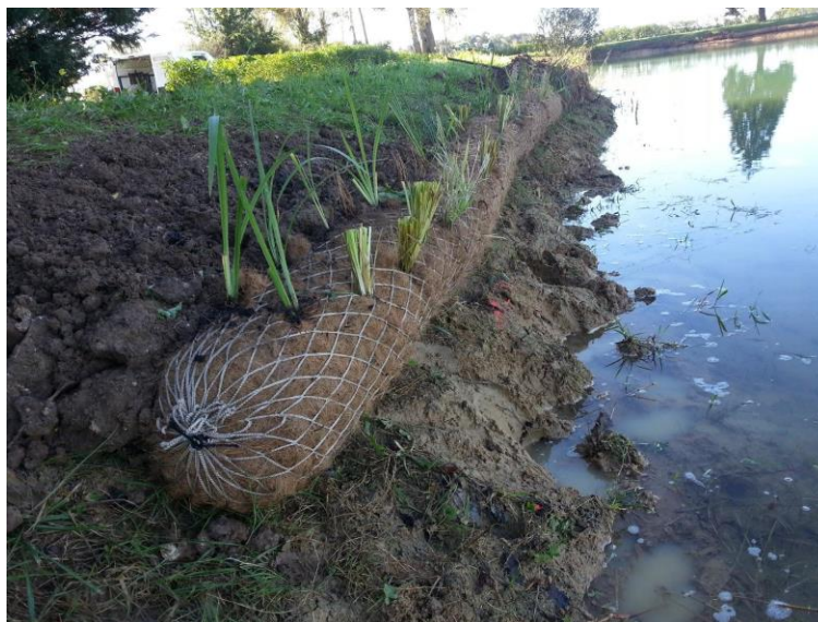
FIGURE 18 : INSTALLATION D'UN BOUDIN D'HÉLOPHYTES EN BAS DE BERGE
