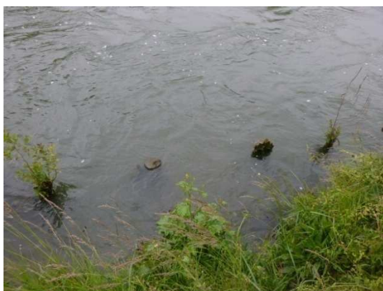
Figure 11 : Focus sur un ancien aménagement (pieutage)
