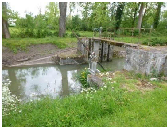
Figure 14 : Focus sur la présence d'un ouvrage
