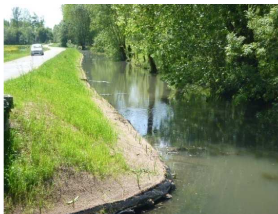
Figure 8 : Vue d'ensemble, aménagement récent sur une berge
