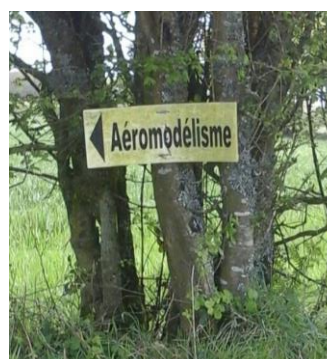
Figure 21 : Préenseigne présentant une activité de loisir non conforme car installée sur un arbre
