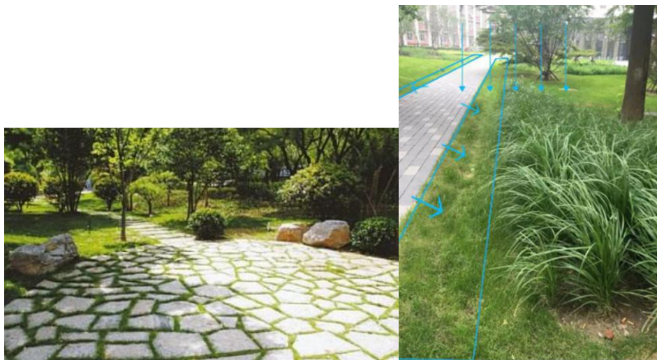
Figure 11, des briques perméables et des espaces verts plus bas que les chemins (Chla.com)
