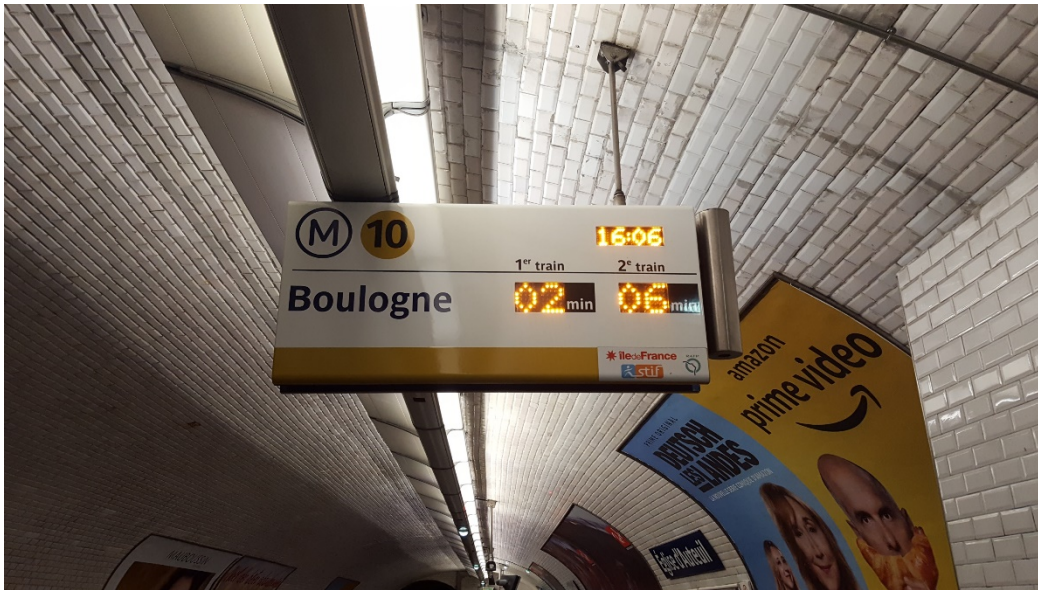
Figure 30 - Ecran d'information des prochains passages fonctionnant sous la technologie SIEL ; auteur : Léo Magat
