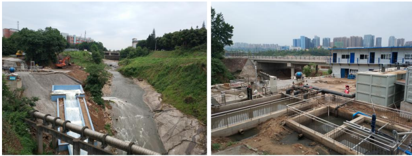
Figure 20, la photo de partie IV-Site de l'évacuation de la station d'épuration
