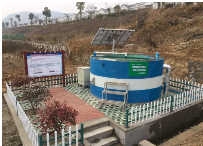
Figure 6, Équipements intégrés de l'infiltration rapide artificielle
