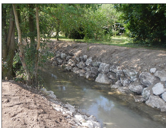
Figure 16 : Enrochement sur une berge (Source : http://syndicat-cisse.fr )
