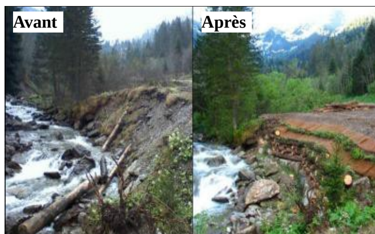
Figure 14 : Mise en place d'un caisson végétalisé (Source : http://www.geni-alp.org )
