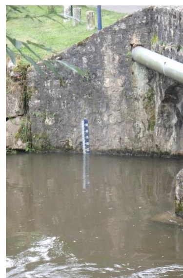
Figure 26 : Echelle limnimétrique sur la route départementale à Augerville la Rivière
