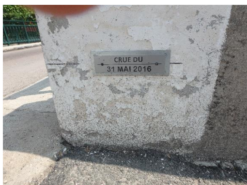
Mareau-aux-Bois rue du bourg Mareau-aux-Bois route de
