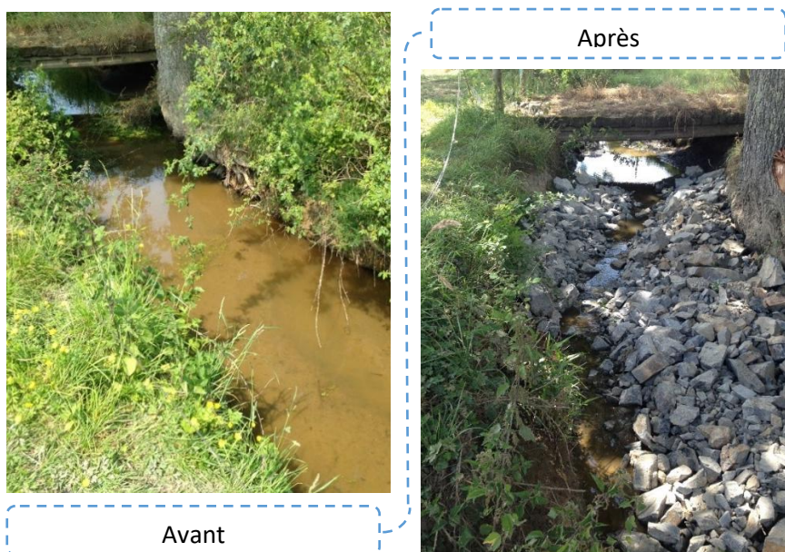
Figure 16 : Exemple de travaux réalisés sur le Ruisseau de l'Etang
