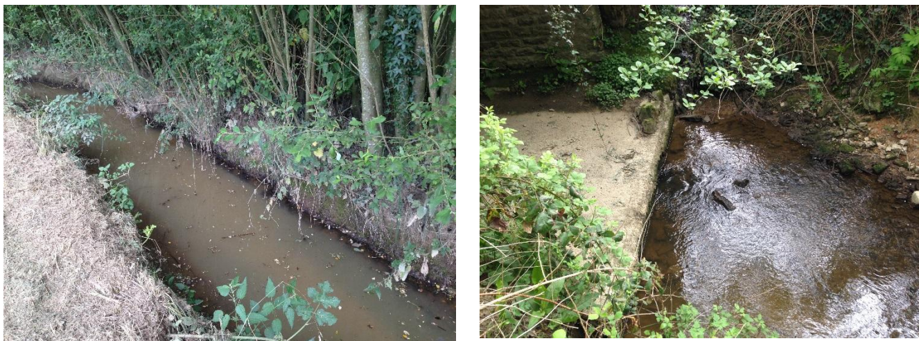
Figure 9 : Photos d'altérations morphologiques et de rupture de continuité sur le Ruisseau de l'Etang
