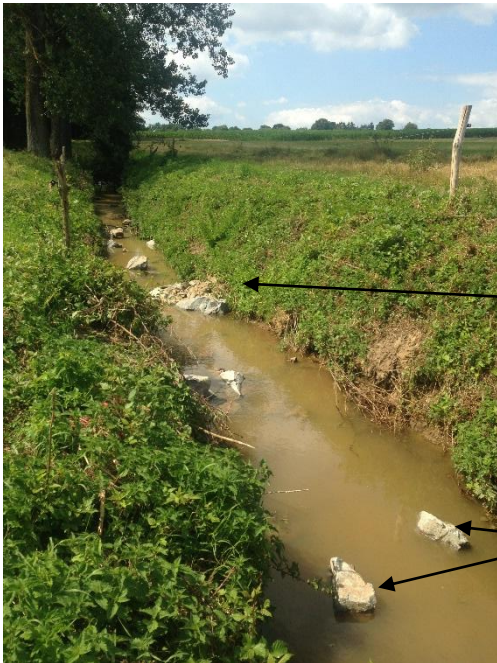
Figure 22 : Pose de blocs épars et création de déflecteurs sur le cours d'eau de la Galesnais (juillet 2018)
