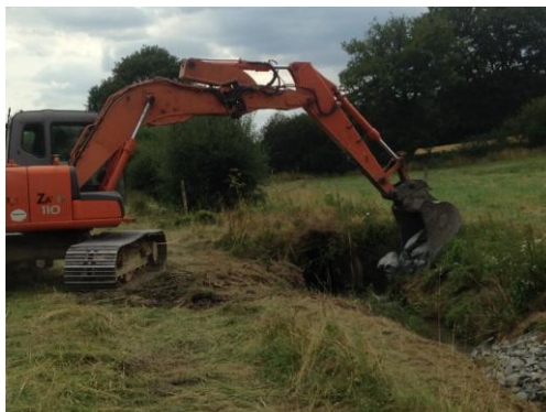
4. Dépôt des cailloux dans le cours d'eau
