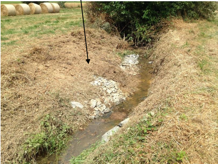
Figure 23 : Adoucissement de berges (Ruisseau de l'Etang, juillet 2018)
