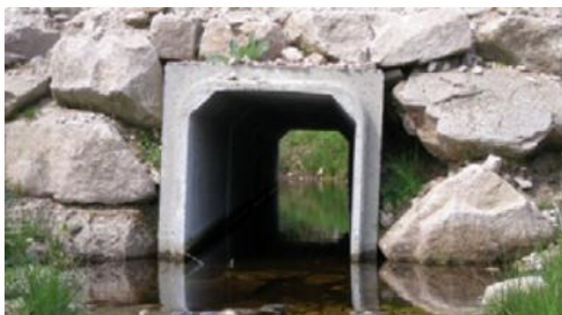
Figure 27 : Photo d'un pont cadre
