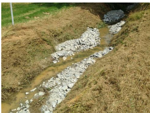
5. Création des aménagements (banquettes, blocs éparés...)
