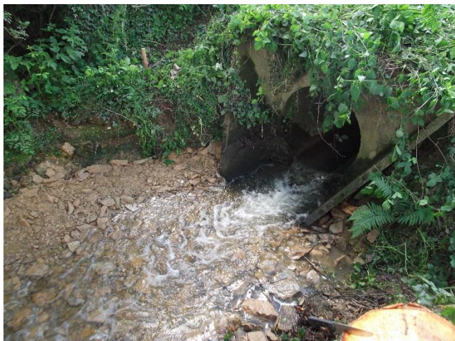
Figure 25 : Aménagement d'une rampe en enrochements sur le cours d'eau de la Galesnais, 2013)
