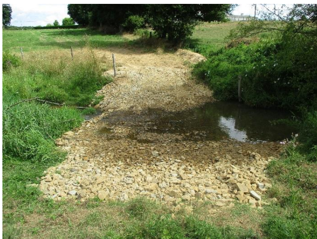
Figure 26 : Aménagement d'un passage à gué (Bois Cornillé, juin 2018)
