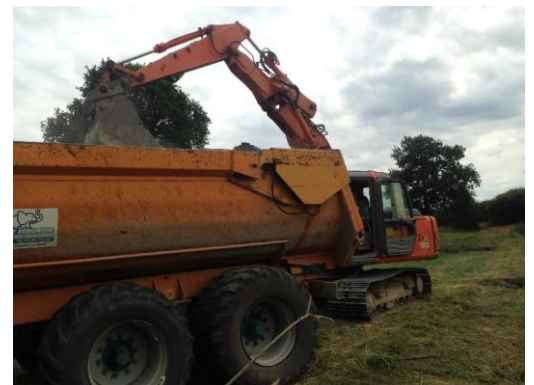
3. Prise des cailloux par la pelle directement dans la remorque
