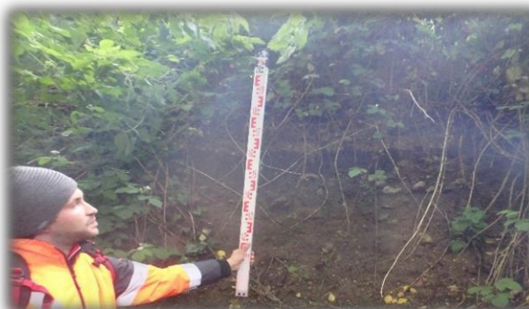
Relevé d'une érosion de berge. Source : Suez 2018
