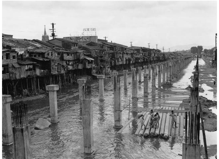
Figure 25 Construction de la route sur la Cheong Gye Cheon - 1965 - auteur inconnu - http://blog.daum.net/gmania65/436
