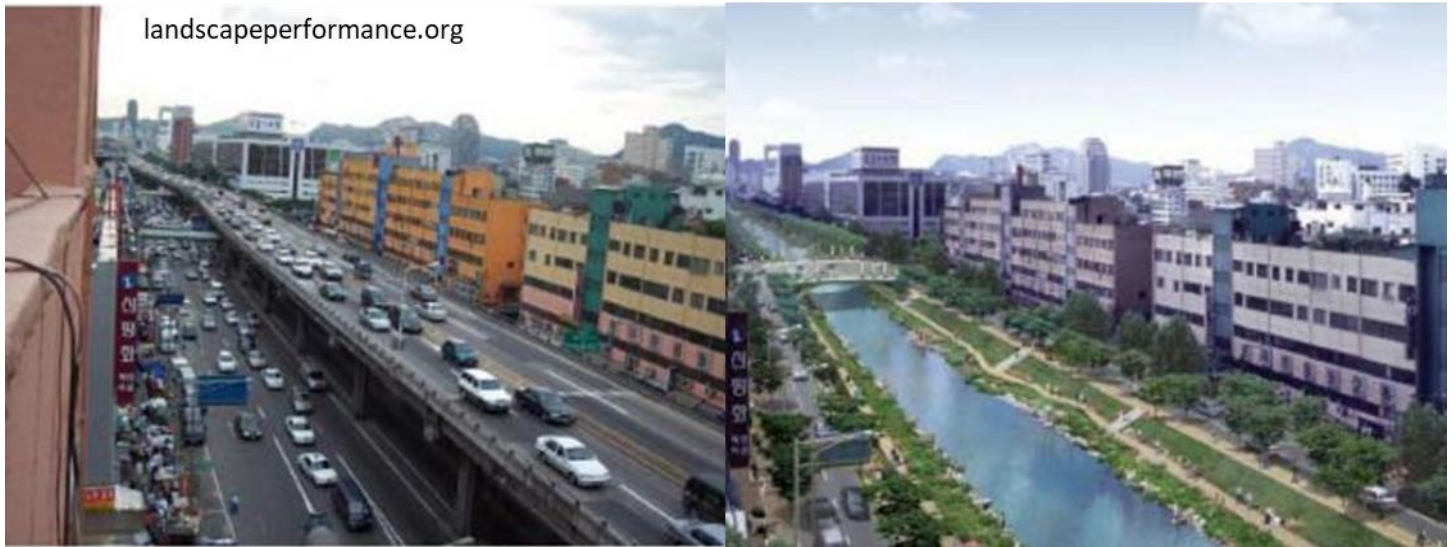
Figure 21 Vue avant et après travaux de la Cheong Gye Cheon
