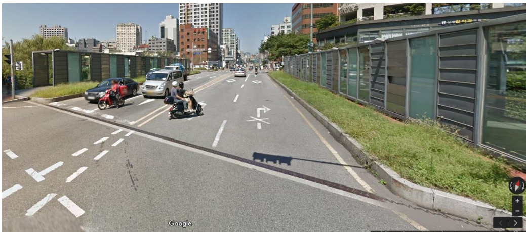
Figure 24 Mur anti-bruit sur un pont surplombant la Cheonggyecheon
