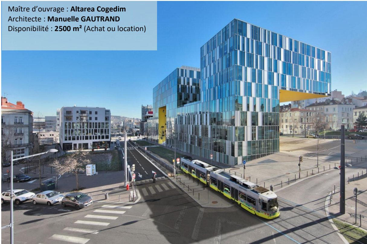
Figure 50 : La cité Grüner, une offre tertiaire dans un immeuble au design contemporain Source : EPA Saint-Étienne / Studio Caterin
