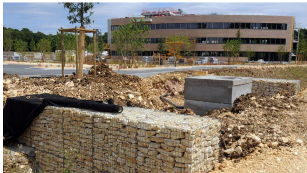
Début des travaux pour le Parc d'Activités
