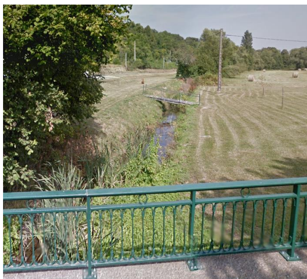
Figure 4 : Pente forte des berges dues au curage (Source : Google Maps)
