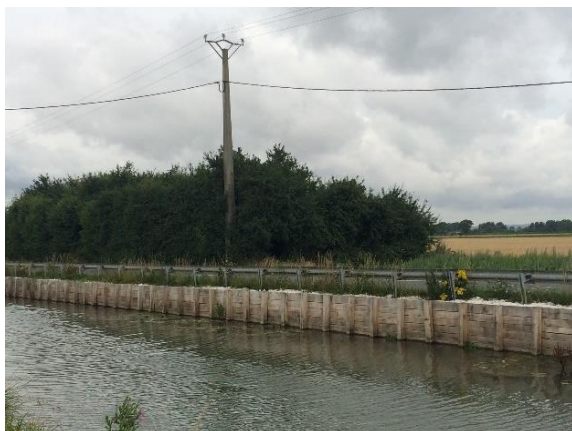
Figure 7 : Berge en tunage bois. (Source : FALCONNET Madisone)
