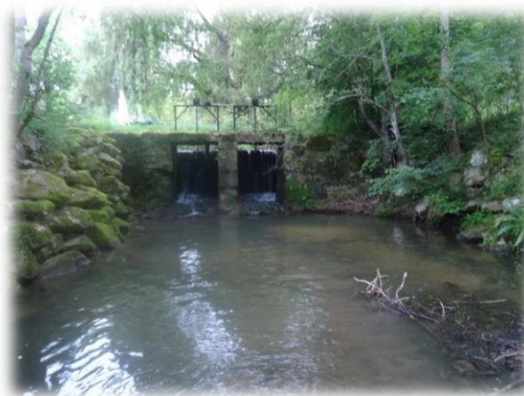
Figure 10 : Exemple de vannes de moulin présentant un obstacle à la continuité écologique de la Dourdèze
