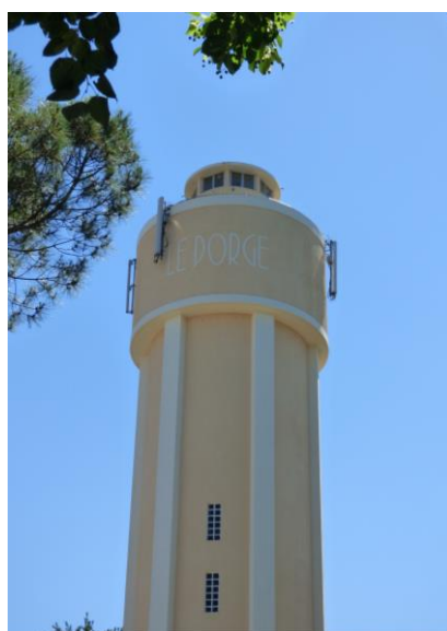
Figure 79. Château d'eau du Porge
