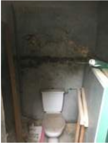
Toilettes dans la grange
