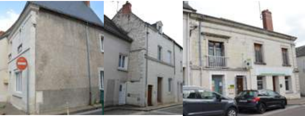
PHOTOGRAPHIES MONTRANT L'HÉTÉROGÉNÉITÉ DES FAÇADES
