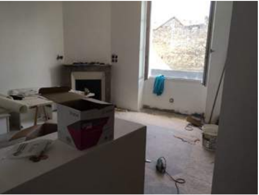
Pièce à vivre rénovée logement 2
