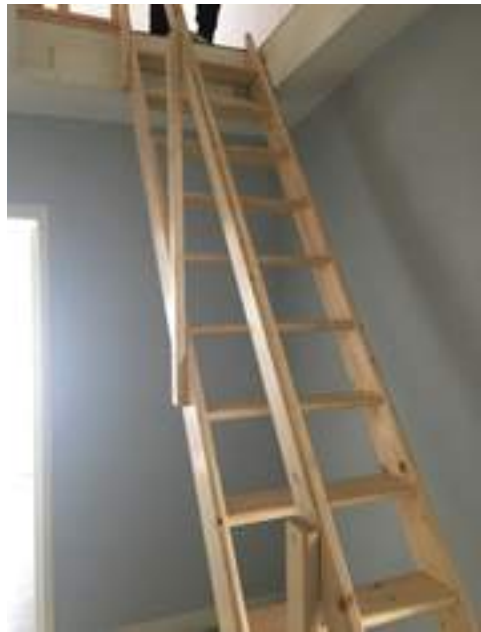
Escaliers pentus pour accéder au R+2
