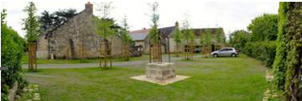
PHOTOGRAPHIE D’UN PARKING VÉGÉTALISÉ AVEC FALITAL® (SOURCE : CHAUSSEE-VEGETALE.COM)
