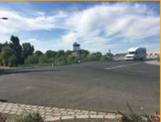
Carrefour dont les cheminements piétons ne sont pas facilités
