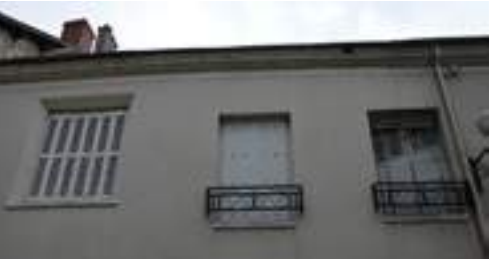
PHOTOGRAPHIE PRÉSENTANT L'HÉTÉROGÉNÉITÉ DES OUVERTURES
