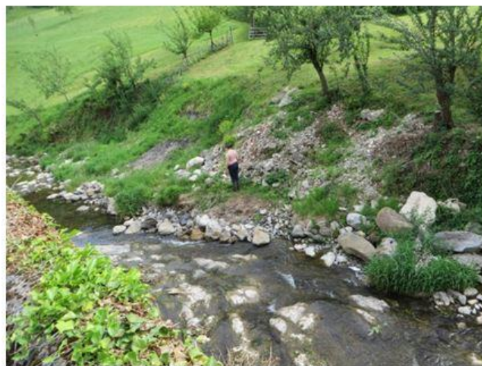
FIGURE 2: EFFONDREMENT DU JARDIN DE M. PRETOU JEAN
