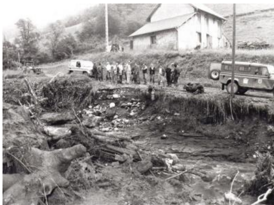
Figure 1 : Les dégâts de la crue du 16 juin 1992 (Source : C-PRIM, 2010)
