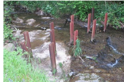
Figure 7 : Un piège à embâcles sur l'Arric
