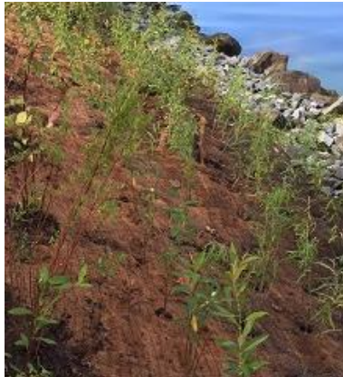
Figure 21 : Protection de berge par la mise en place de plants sur du géotextile (Source : http://www.affq.ca )
