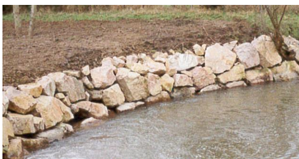
Figure 24 : Protection de berge par enrochement (Source : www.entreprise-delamare.fr )
