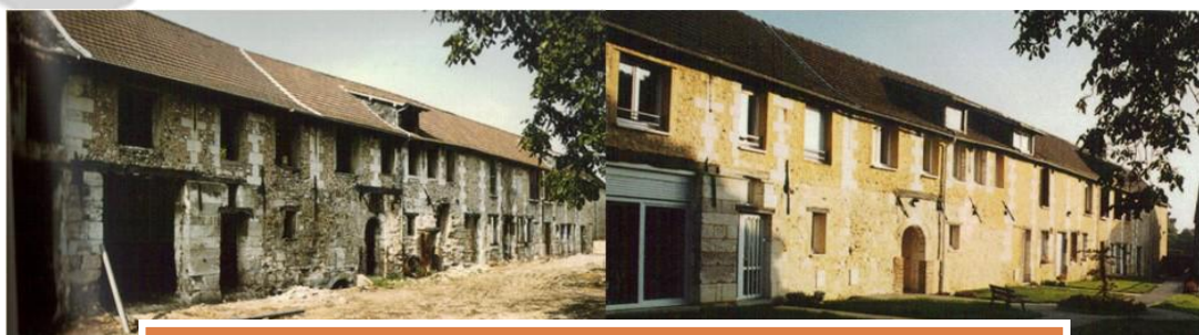
Figure 1 - Exemple de réhabilitation d'une vieille ferme en logements à Freneuse (76)
