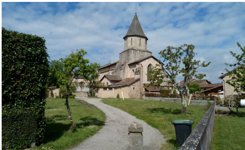
Figure 11 : Photographie de l'église de Saint-Auvent Source : Etudiants Polytech Tours
