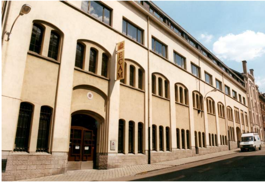
Figure 31 : Photographie de la façade de l'Ecole centrale des Arts et Métier de Saint-Gilles
