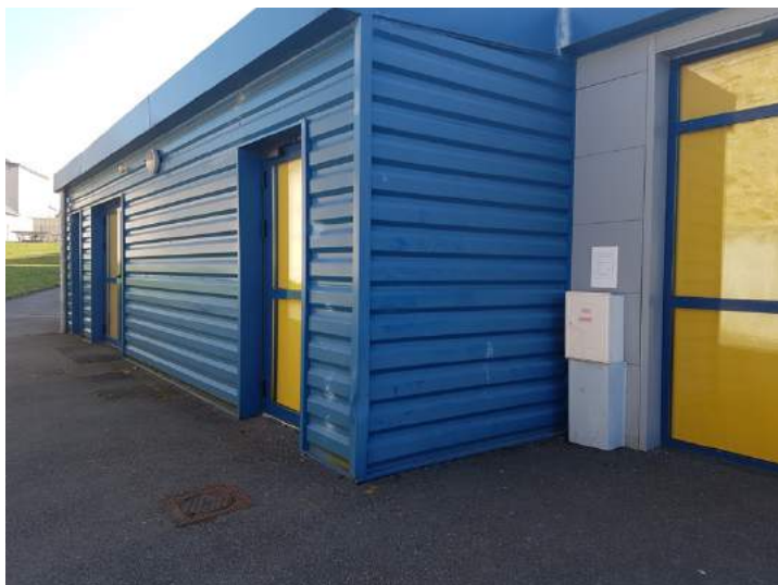
Figure 22 : Salle polyvalente vue de l'extérieur
