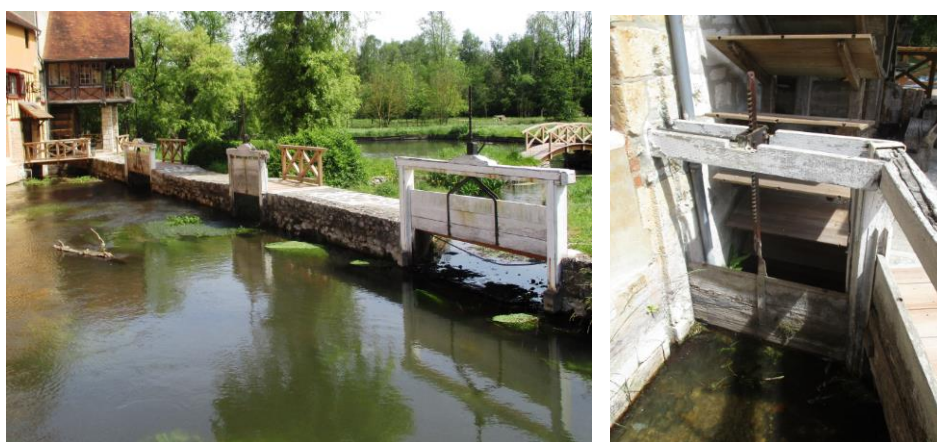
Figure 10 : Vannes (V1 à V3) à gauche et vanne usinière V5 à droite
