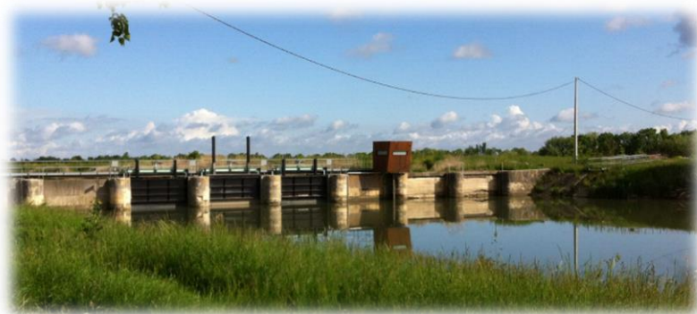
Figure 8 : Photographie du barrage et de la passe des Enfreneaux côté Amont
