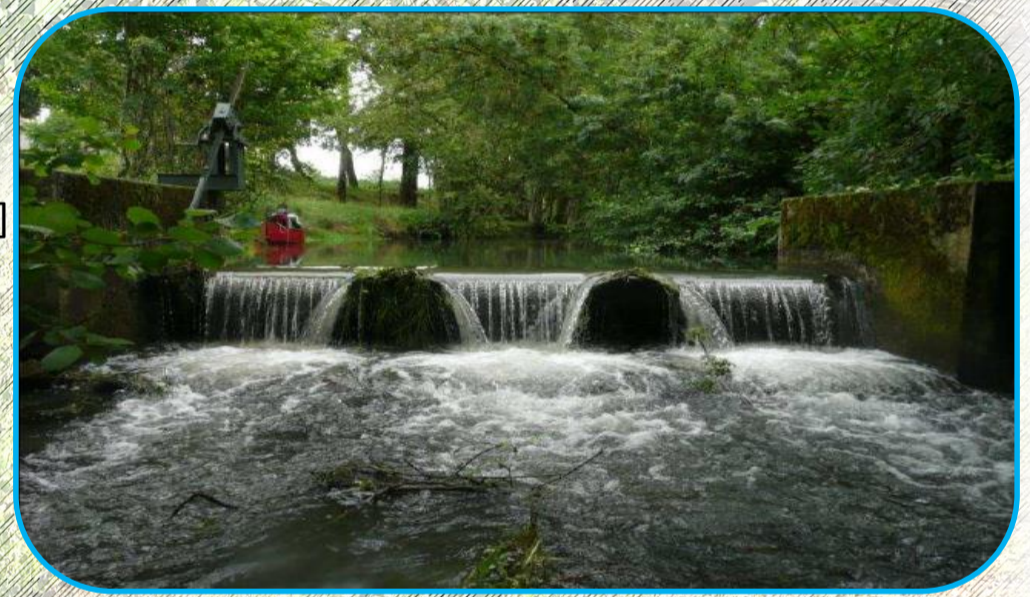
Exemple d'un ouvrage transversal sur la Clouère Source : Théma environnement, 2011 [4]
