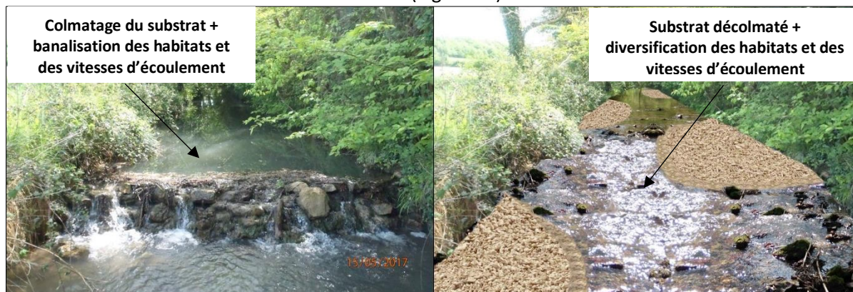
Figure 17 : Exemple d'effacement d'un seuil artificiel et d'aménagement de banquettes alternées sur le ruisseau de Jolines
